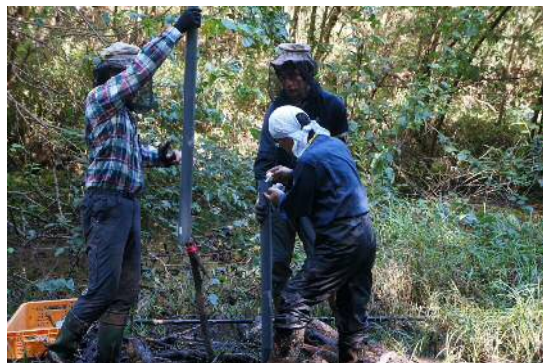
写真B-1 現地調査の状況
