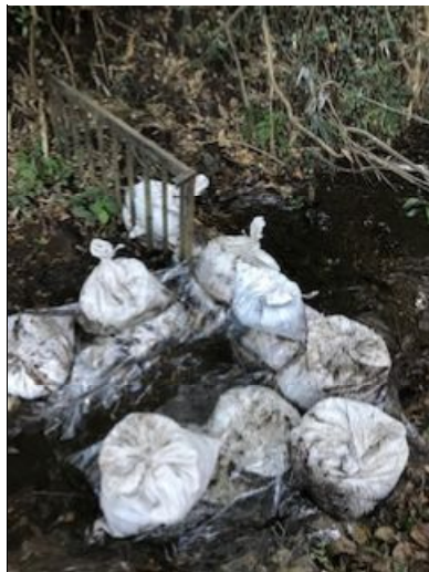
写真-2.湧水の水路への流入口
