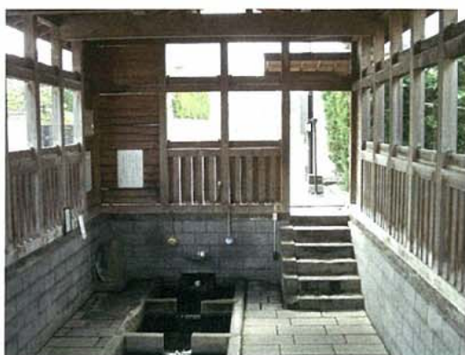
図 4. 富田の清水 ひしゃくが常備されており、現在も使われている様子 がうかがえる。非常にきれいに整備されている。
