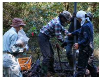
井戸管の建込み状
