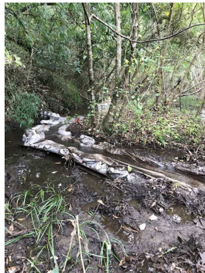
写真7 泥や枝木を撤去し、土嚢を回収して復旧しました。相当の水が水路を滔々と流れています。
